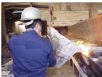
Operação de vazamento
