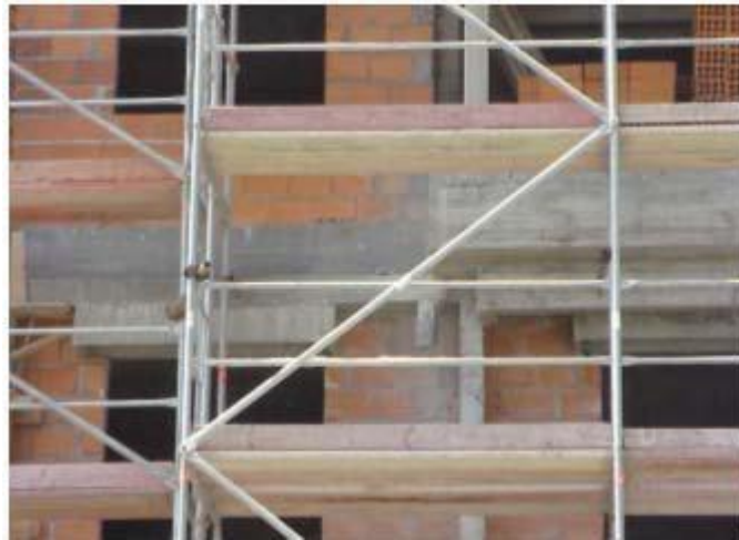
Exemplo de guarda corpos e rodapé num andaime.
